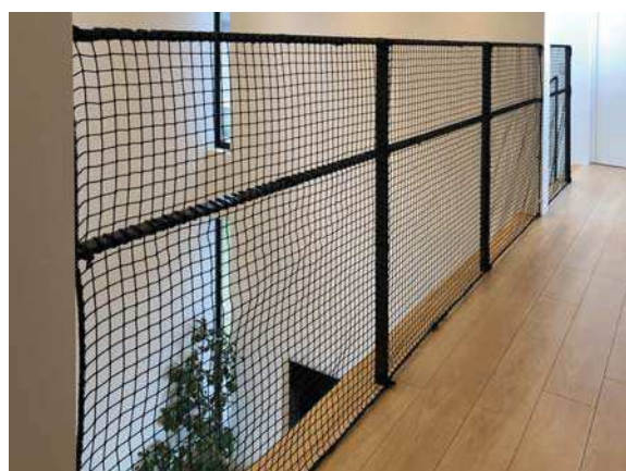
階段手すりネット取付例
